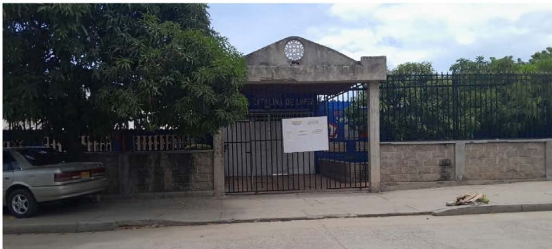
Sola se encuentra la sede educativa Celia Catalina de López por falta de agua, entró en cese de actividades.
