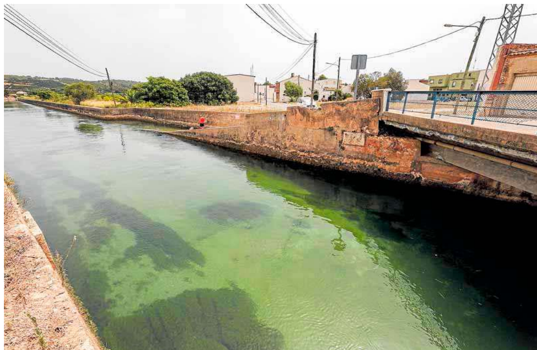
Una canalización de la Acequia Real del Júcar. JESÚS SIGNES
